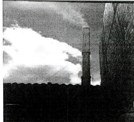
Fotografía No 4. Ducto de desfogue
